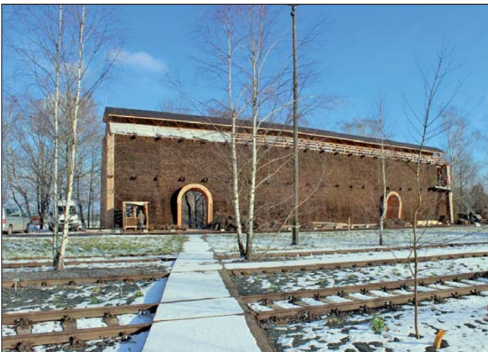
Die letzten Bündel der 700 m 3 Schwarzdornzweige werden in das Gradierwerk eingebracht.
