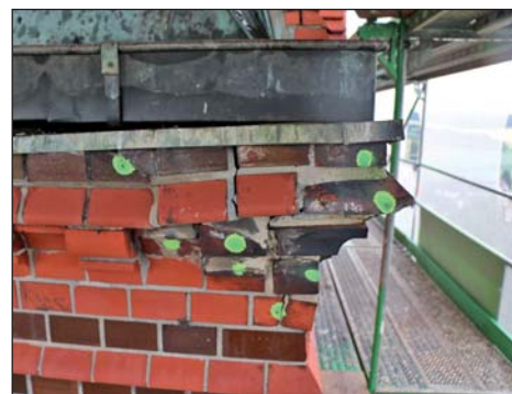
Durch Feuchtigkeit verschobenes Mauerwerk
