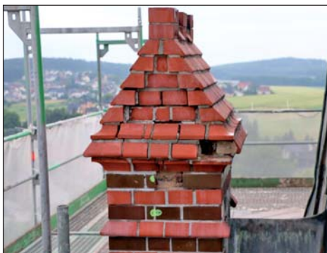
Gelöster Ziegel mit witterungsbeschädigtem Türmchen
