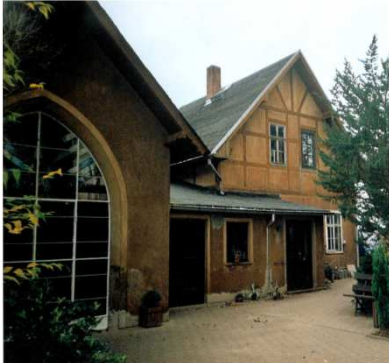
Feierhalle mit ehem. Friedhofswärtergebäude
