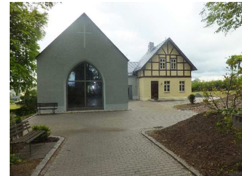
Feierhalle mit ehem. Friedhofswärtergebäude
