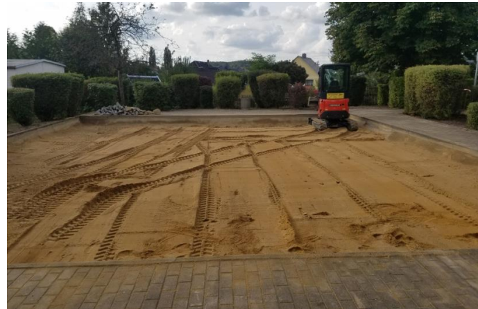
während der Bauphase
