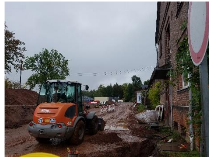
während der Bauphase
